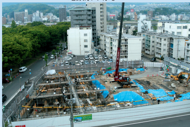
現在の工事状況
